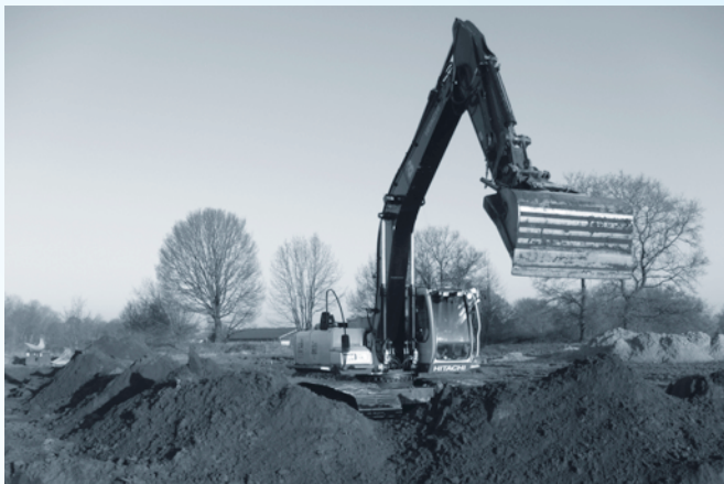
• Aanleg van een natuurvriendelijke oever. (foto: Beeldbank Waterschap De Dommel)
